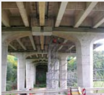
Toutry Bridge, (FR)
